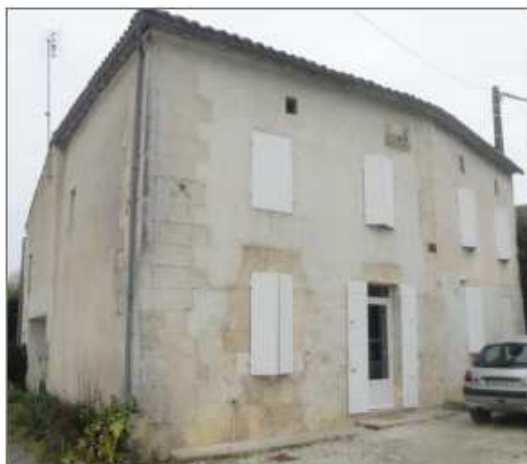
Maison à étage surmonté de combles dans le hameau de Chez Pierrot
