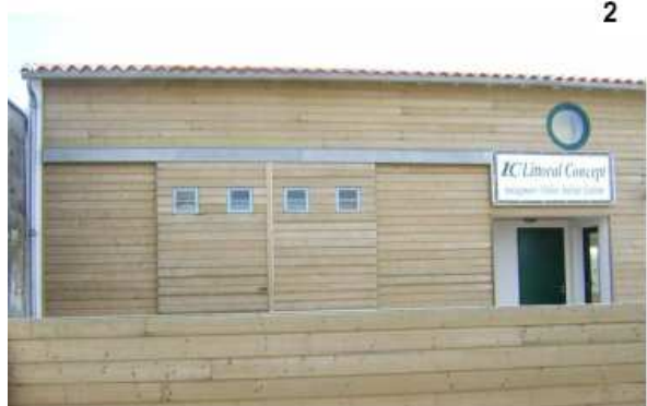
Bâtiment d'activité en bois
