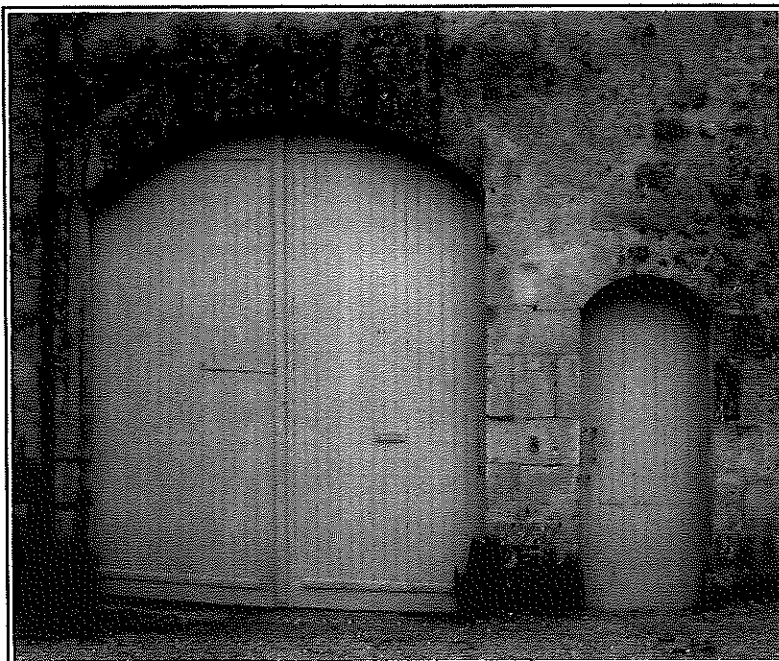
Portail à voûte dans le bourg
