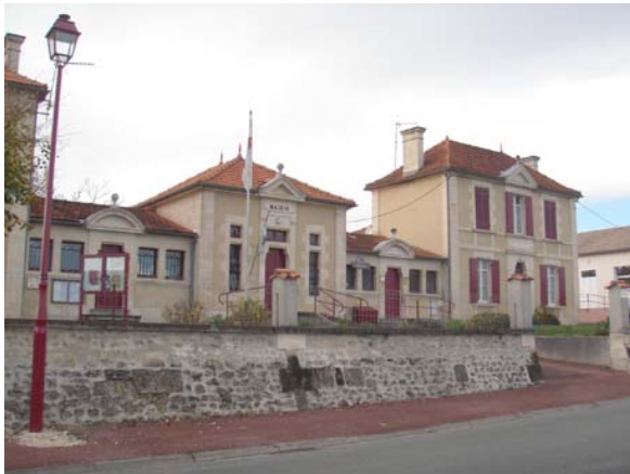
La Mairie /école dont une partie est utilisée comme bureau de poste
