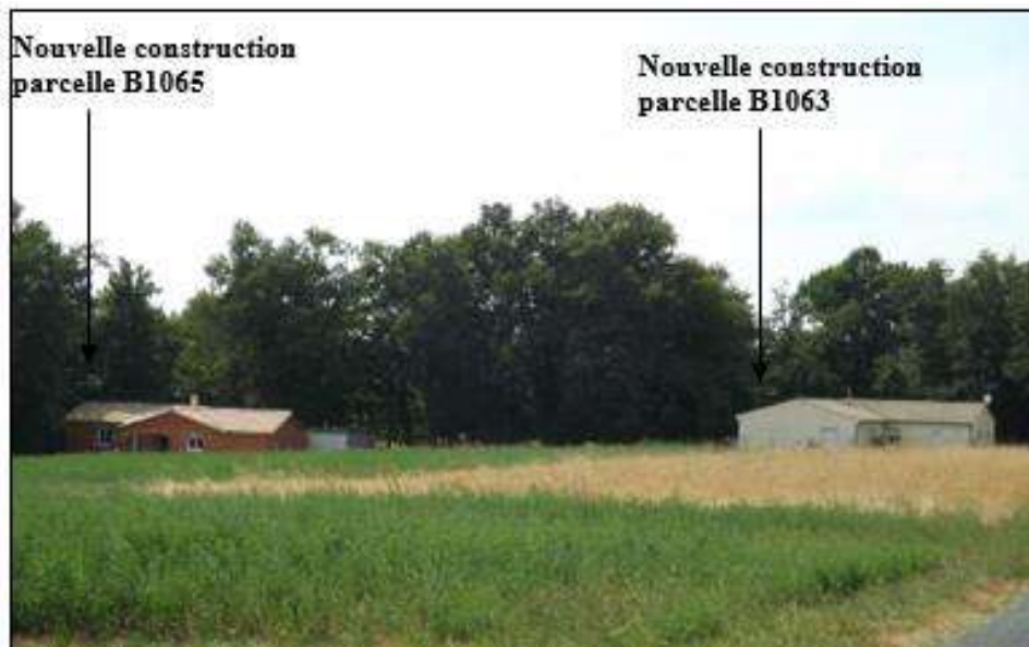
Nouvelles constructions dans le lotissement communal du Plantis, vue de la RD255E2 (Source : SIVOM de Montendre)
