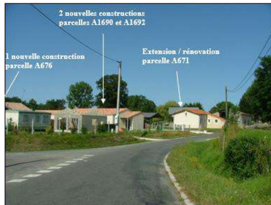
Nouvelles constructions sur les parcelles A671, A1690, A1692 et A676, vue de la RD156 Source : SIVOM de Montendre
