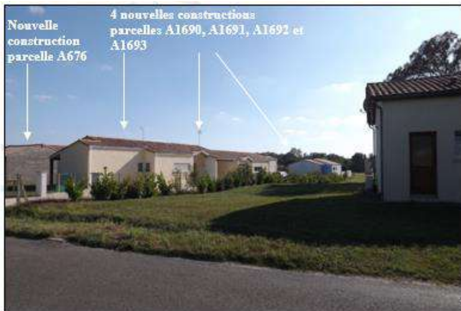
Nouvelles constructions sur les parcelles A676, A1690, A1691, A1692 et A1693, vue de la RD156 en sortant du Bourg
