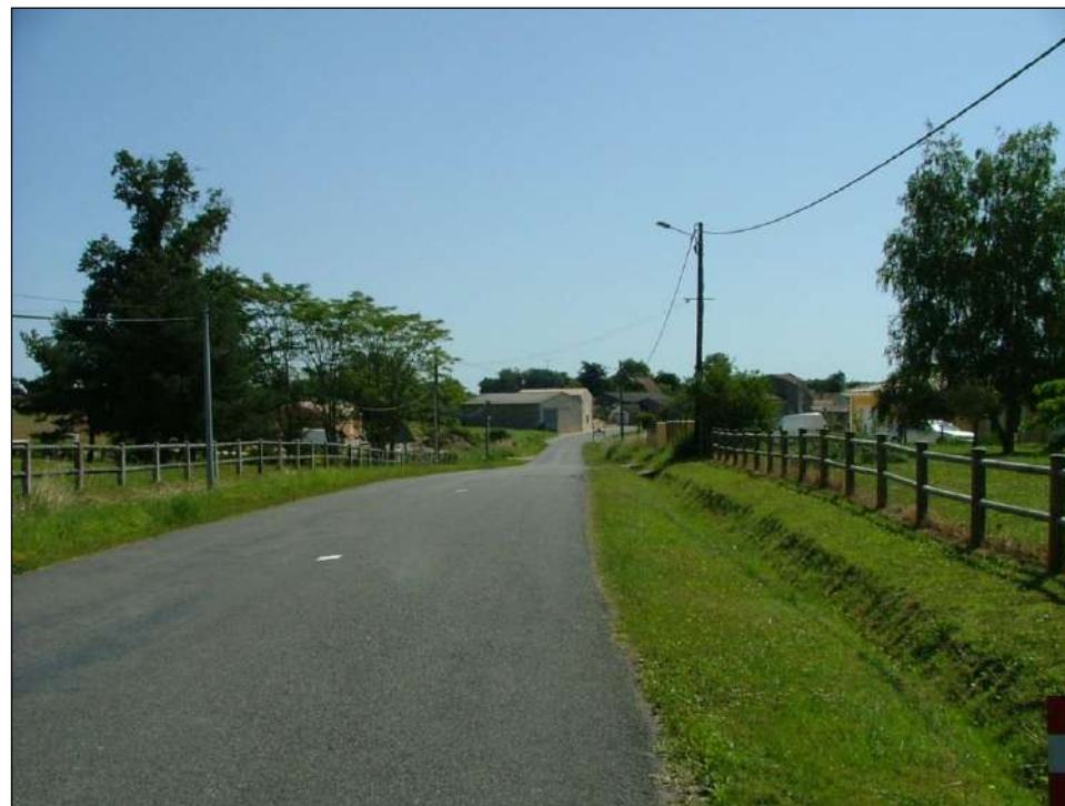
La RD156, vue des Gireauds vers le Bourg (Source : SIVOM de Montendre)
