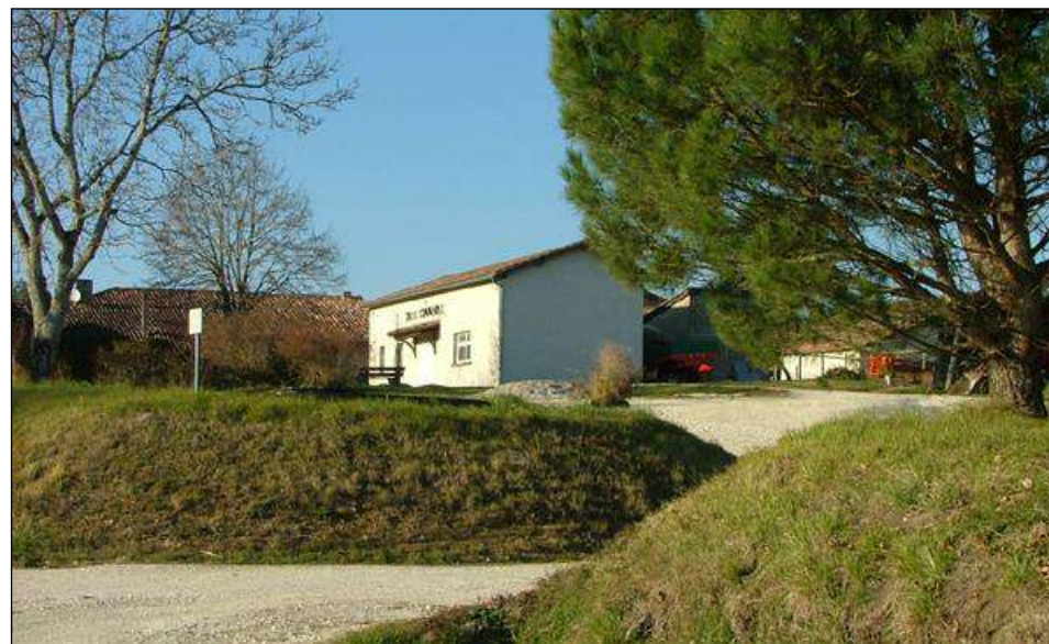
Salle Communale située dans le Bourg à proximité de la Mairie (Source : SIVOM de Montendre)
