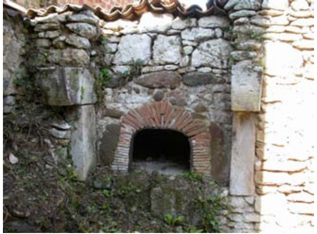
Four à pain (Pas du Marais)
