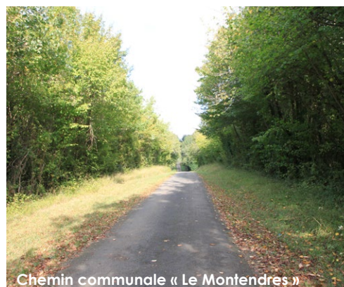
Chemin communale « Le Montendres »
