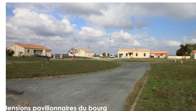
Extensions pavillonnaires du bourg
