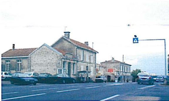
Photographie n°13 : Vue sur la RN137 Côté « La Jard »
