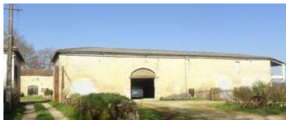
Imposante grange du Domaine de la Cour munie d'un vaste porche cintré
