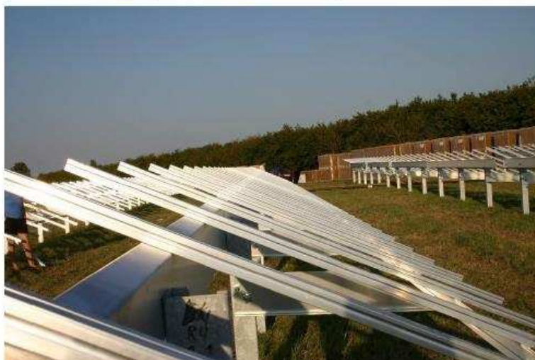
Photo 67 : Exemple de structures porteuses
