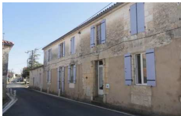
Maison de bourg à un étage implantée en bordure de rue
