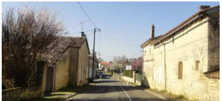
Maisons rurales et maisons de maîtres bordent la rue principale
