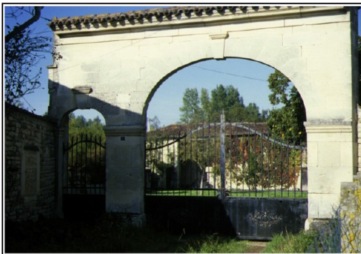
Portail, 5 rue de la Forge
