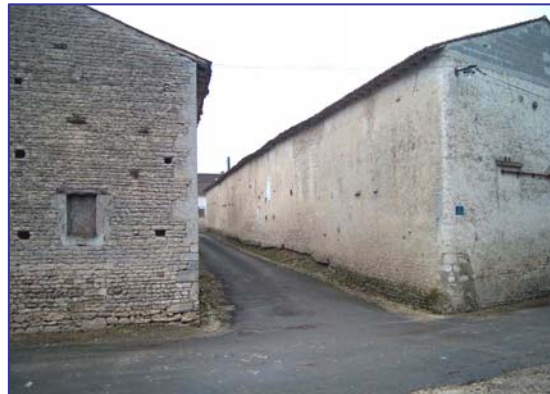
Présence de multiples Murs en moellons
