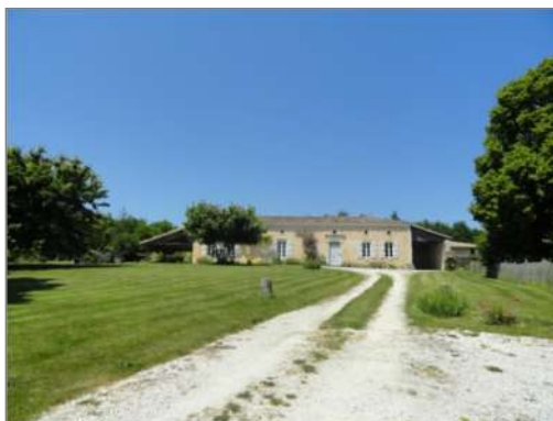
Figure 91 : Rénovation à Ferchebois Source : Mairie d'Expiremont
