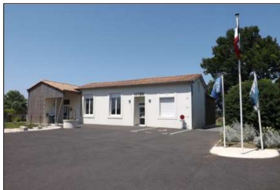
Figure 108 : La Mairie rénovée d'Expiremont (SIVOM de Montendre)
