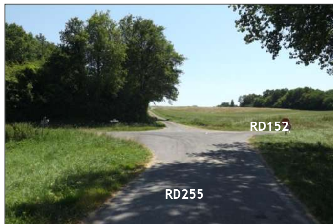
Figure 104 : Croisement des RD152 / RD255 (SIVOM de Montendre)
