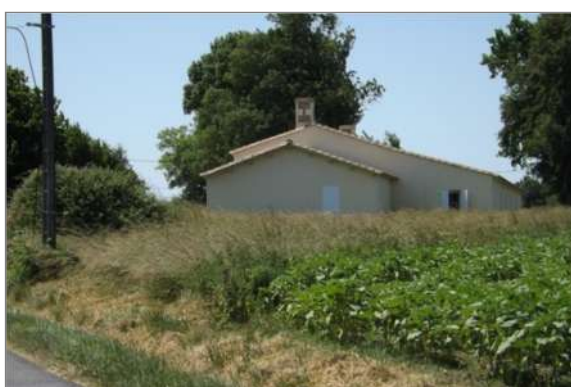
Figure 89 : Rénovation Les Bouyers (SIVOM de Montendre)
