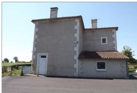
Figure 96 : Logement communal au Bourg d'Expiremont (SIVOM de Montendre)
