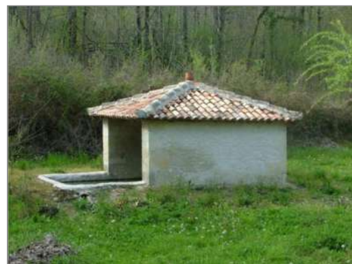
Figure 67 : Lavoir rénové (SIVOM de Montendre)
