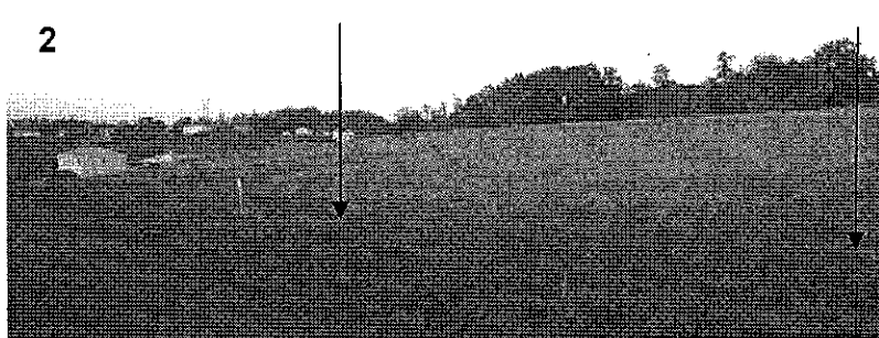
Photos 1 et 2 : environnement urbain et paysager des terrains qui se situent entre deux secteurs urbanisés. Sur la photo 2, les piquets attestent d'un projet de construction neuve en cours d'instruction. Les flèches indiquent l'emplacement des parcelles 28 et 29
