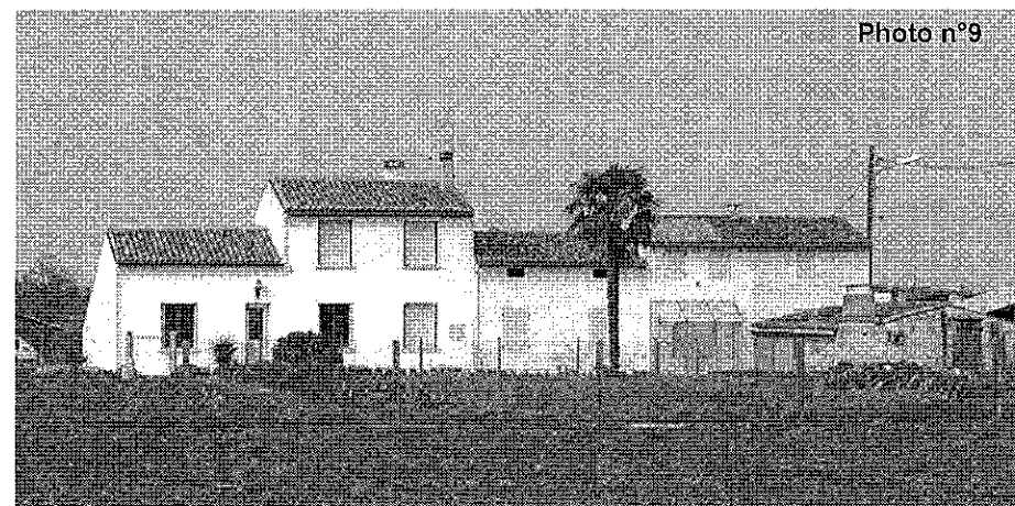
Un exemple de restauration rigide au moulin des Fougères (enduit épais qui recouvre indifféremment moellons et pierres de taille, proportion des ouvertures non conservées, remplacement des volets battants)
