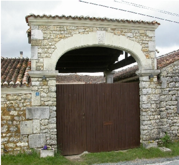
Portail avec pilier et ornements (La Touche)
