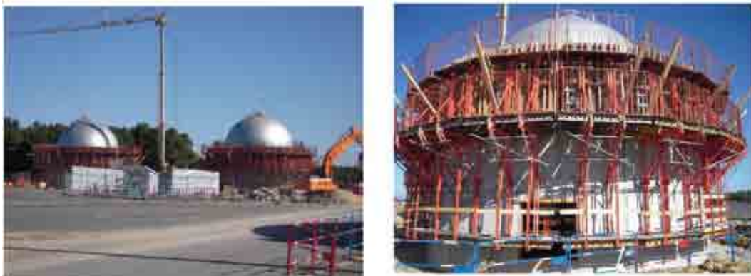
Photographies des travaux sur les coques des citernes, source DREAL 2012.
