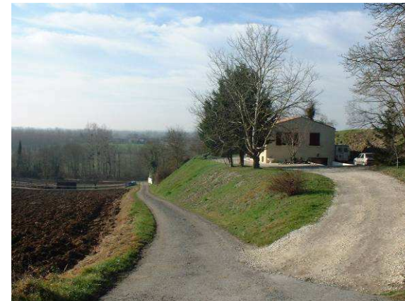
Construction neuve à La Roche
