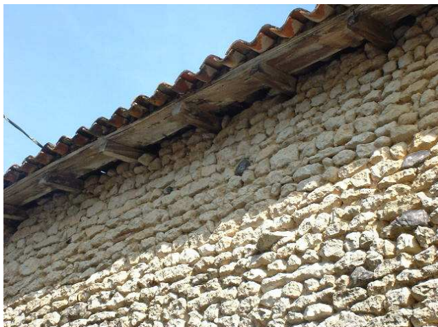
Détail d'un mur en moellon, Bas-bourg
