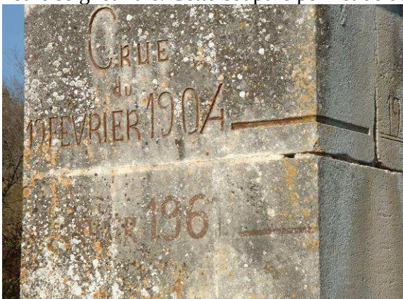
Détail d'un pilier de portail à l'entrée du bourg portant la marque du niveau des crues de 1904 et 1961
