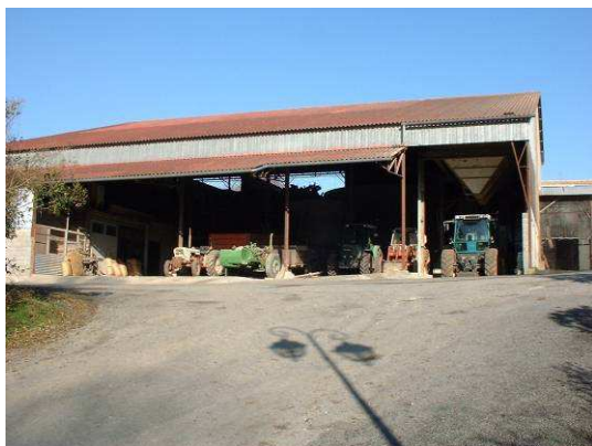
Exploitation agricole à l'entrée de Dompierre
