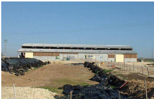
Nouvelle stabulation au nord du bourg
