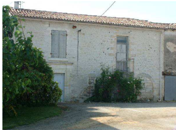
Maison réhabilité à La Morinière
