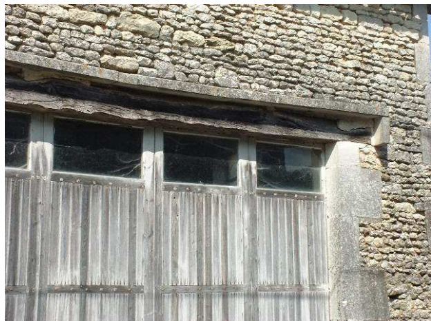
Linteau et mur en moellon d'un garage
