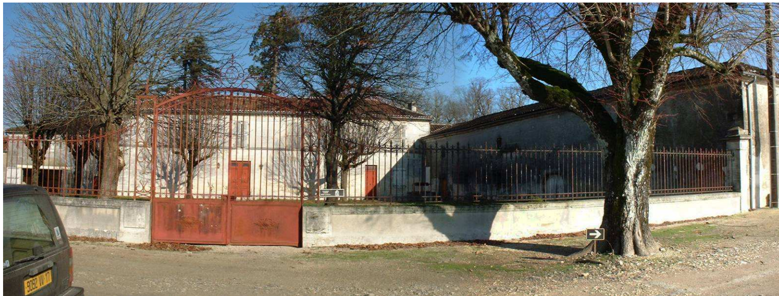
Portail d'entrée et chai sur le côté droit de la ferme de Fonsèche
