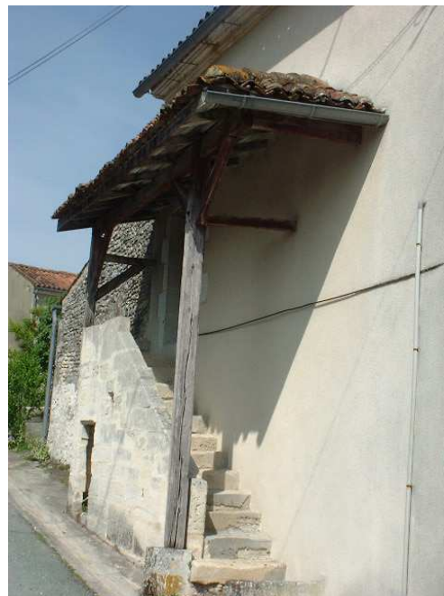
Escalier extérieur typique
