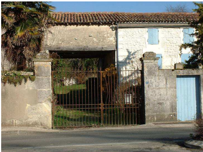
Habitation avec étage mansardé et dépendances dans son prolongement à l'entrée du bourg
