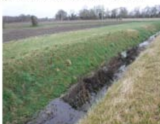
Cours d'eau recalibré et linéarisé
