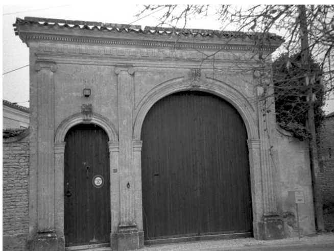
porche avec porte piétonnière
