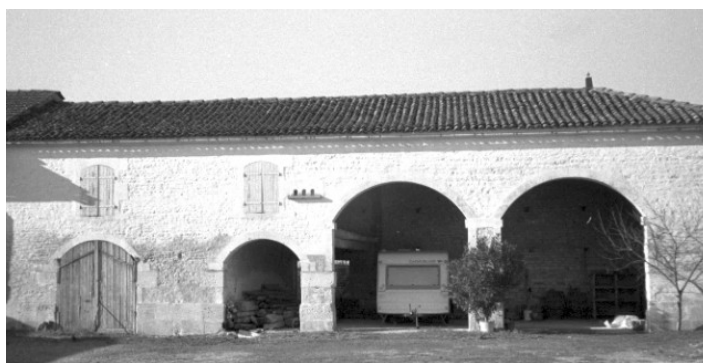
bâtiment agricole à arcades avec pigeonnier à pierre d'envol
