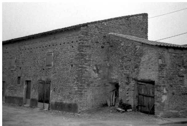
trous de moineaux sur la façade de gauche ; puits couvert à droite
