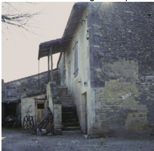
maison Pommeraud : bergerie au RDC, habitat au 1er étage
