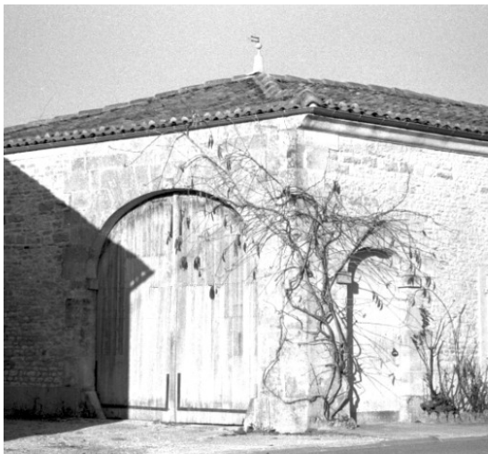
passage couvert avec porche et porte piétonnière
