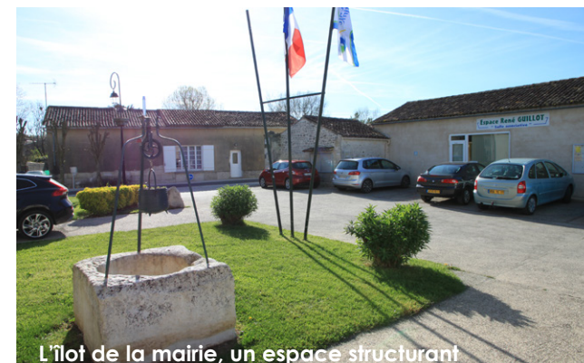
L'îlot de la mairie, un espace structurant
