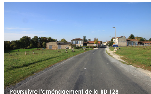
Poursuivre l'aménagement de la RD 128
