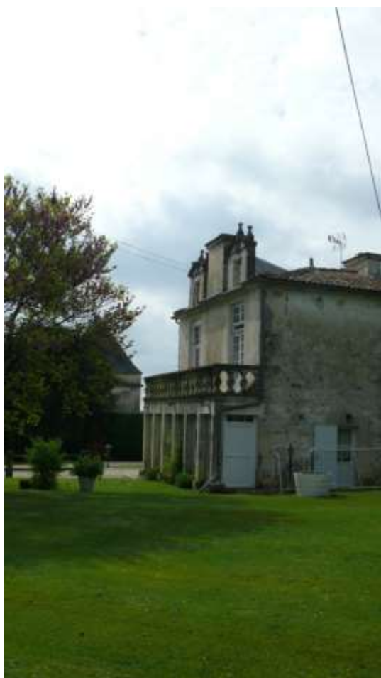
Façade avec la cheminée
