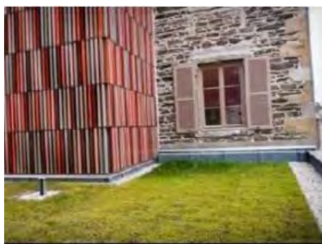
Toiture végétalisée (source : Grand Lyon)
