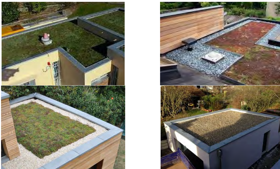
Exemples de toitures stockantes (végétalisées ou non)
