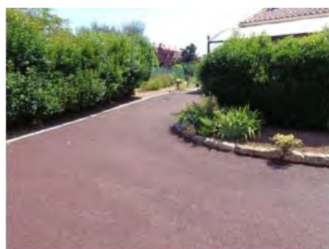
Allée/parking en enrobé poreux (source : Celtivia)
