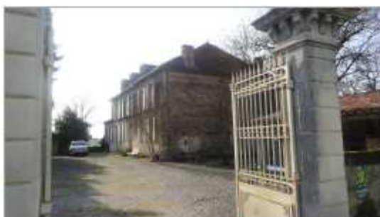
Maisons de maître remarquables situées dans le bourg. Toiture à croupes munies de lucarnes.
