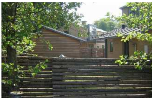
Barrières en bois naturel en limites séparatives
