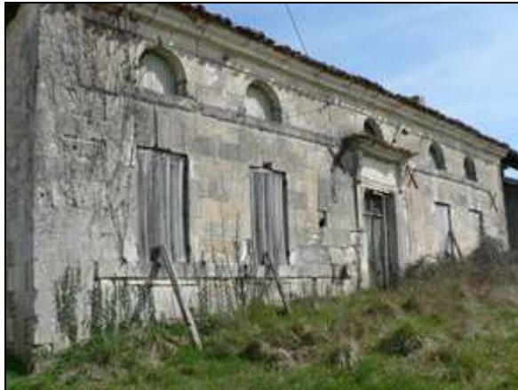
Bâti ancien vacant
