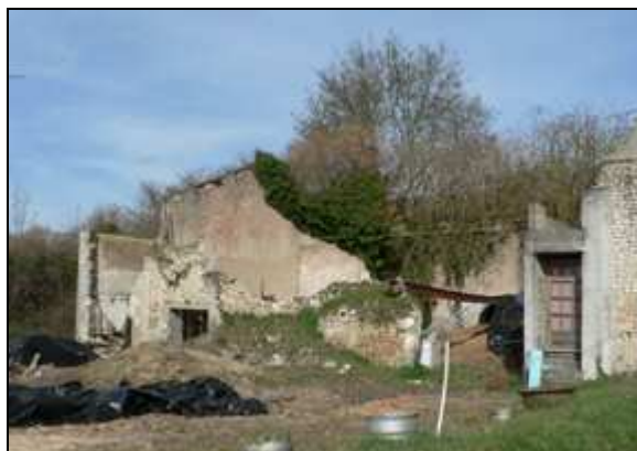
Bâti en ruine (lieu-dit « Le Pont »)
