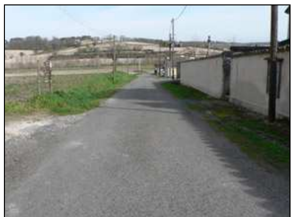
Voie communale dans le bourg
