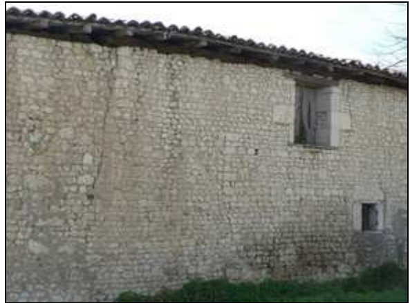
Construction agricole avec ouvertures fonctionnelles et chevrons apparents
