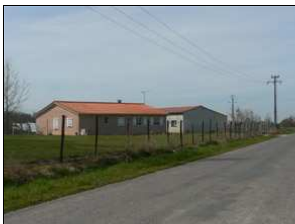
Constructions récentes à l'Est du site
