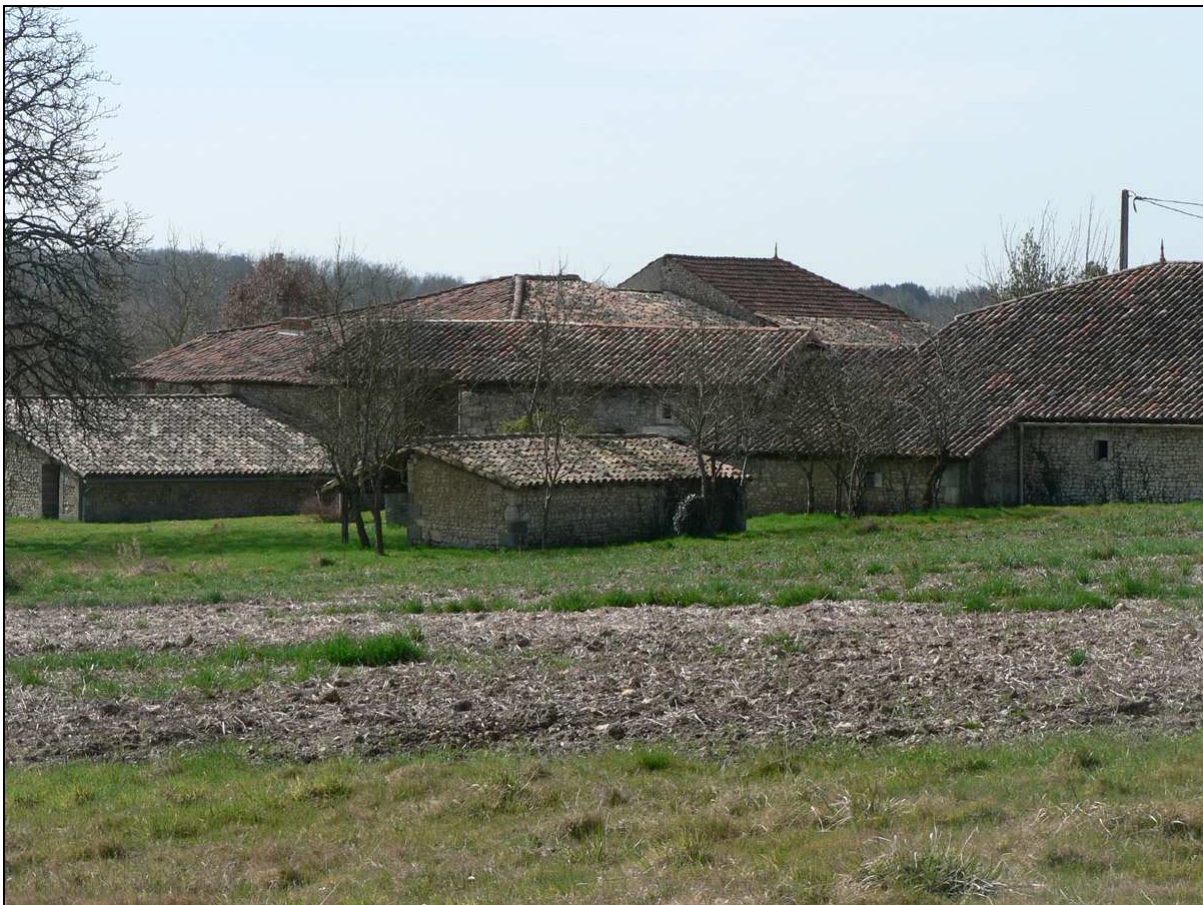
Le lieu-dit « Chez Gautriaud » présente une qualité de bâti remarquable, bien visible depuis la RD 156 et qui constitue une image d'entrée très qualitative de la commune. Une réflexion doit être menée dans le P.L.U. quant à la protection de ce site.
