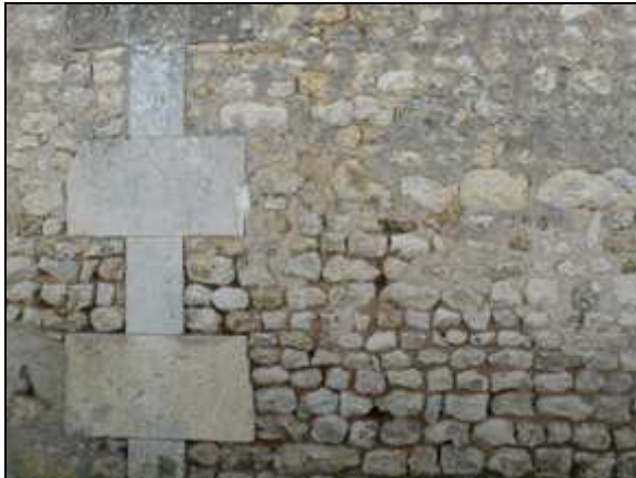
Mur en moellons calcaires enduits et couture en pierre calcaire taillée
