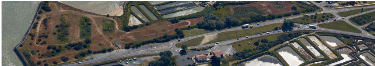
Voie et délaissés de voirie au sortir du Pont (à gauche)
