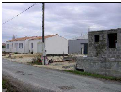
Maisons en bande le long de la voie Rue des Sartières
