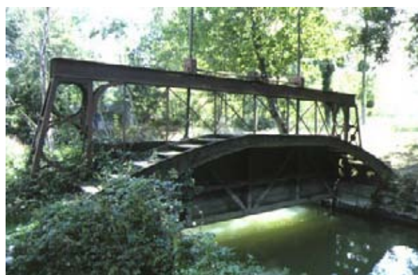
Pont métallique à l'ouest de Bel-Ebat écluses sur un canal de la Boutonne
