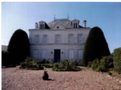
Maison de maître du bourg
