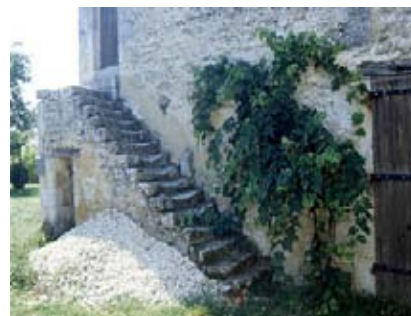
Maison à escalier extérieur
