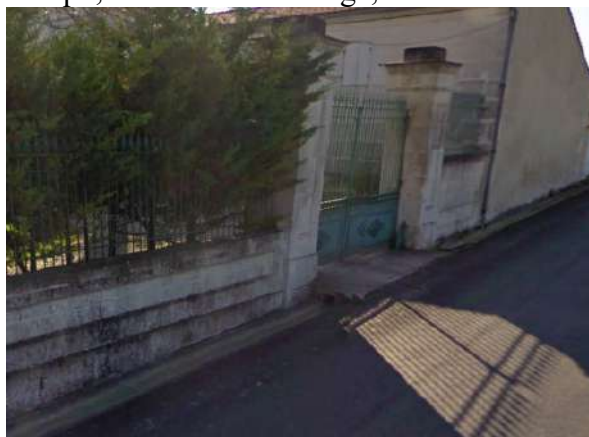
Caniveau le long de la voirie
