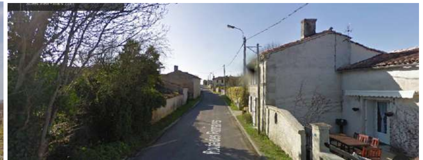
Bâti ancien en accroche sur la voirie, Les Morinauds
