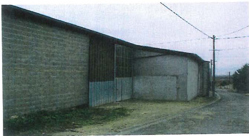
site 1 : enduit du mur, et roses trémières
