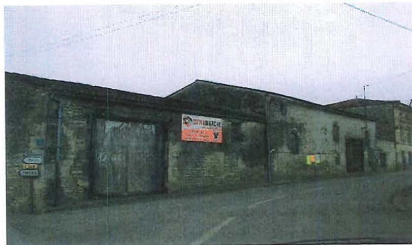
site 10 : pieds de vigne et roses trémières et abandon du panneau
