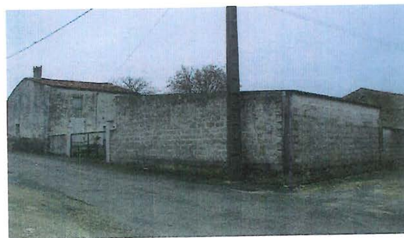
site 4 : enduit du mur, et roses trémières
