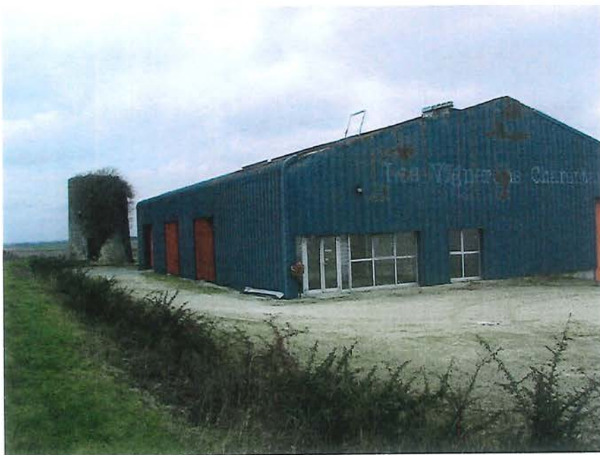
le bâtiment sinistré au Nord de la commune
