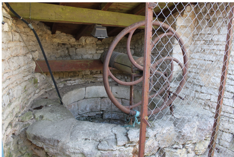
Puits – Le Breuil-Bâtard
