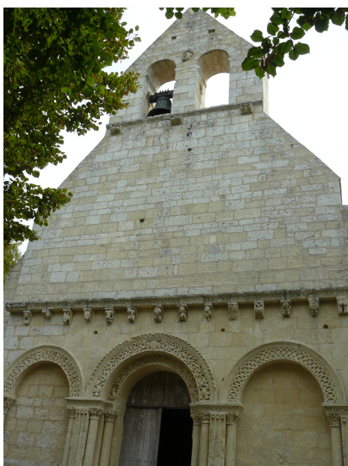
Façade principale – Église Saint-Alban
