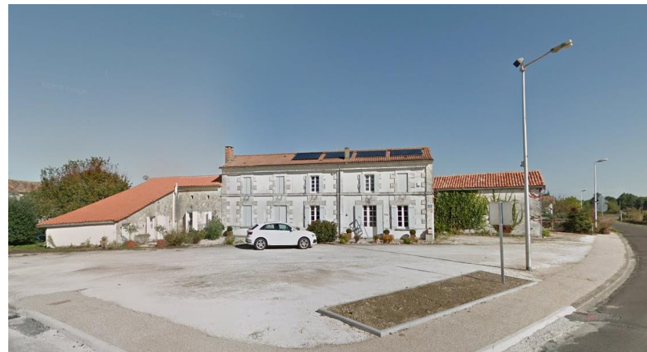
Construction ancienne au niveau de la place de l'Eglise dans le bourg de Boscamnant
