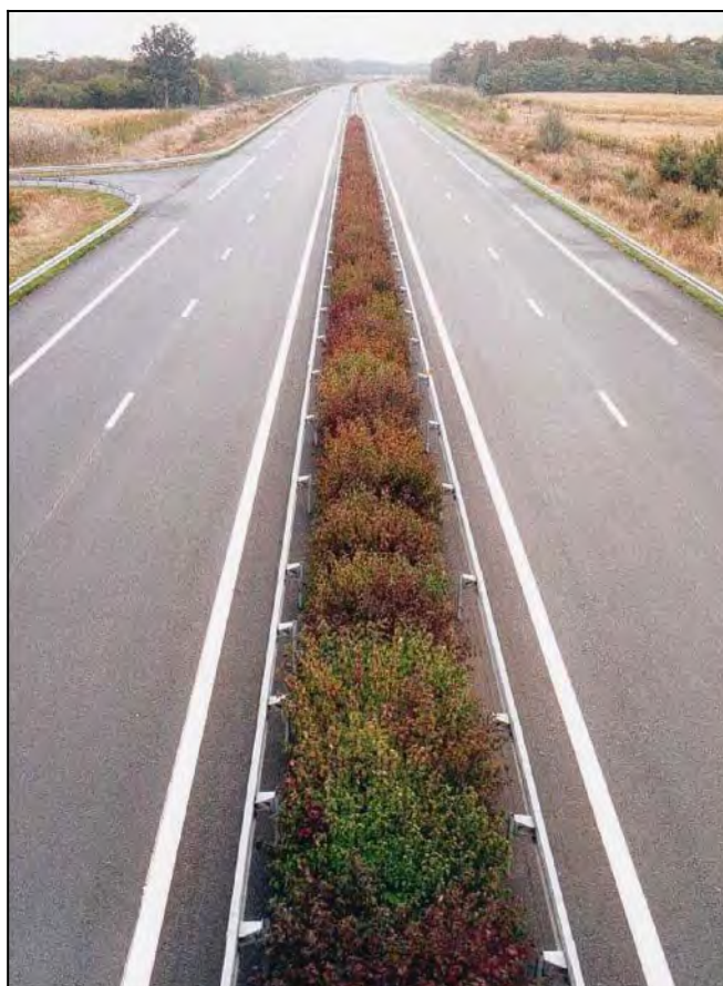
Autoroute Saintes – Rochefort depuis le pont de l'Odérée
