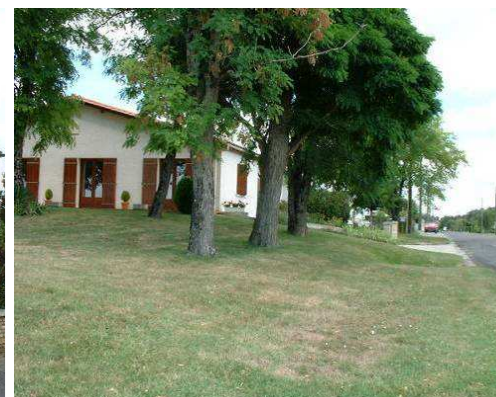
L'absence de clôture, quelques beaux arbres, permettent au paysage de conserver son homogénéité
