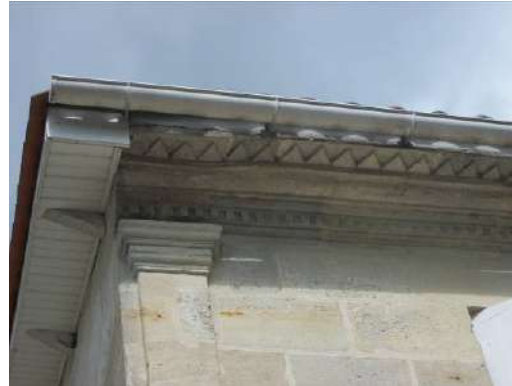
Corniche et pilastre
