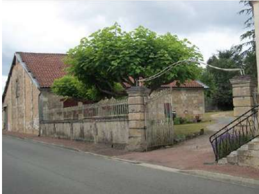
Piliers de portail et mur bahut surmonté d'une grille
