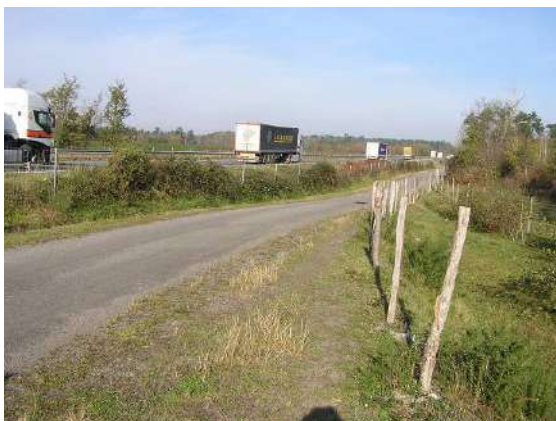
RN10 doublement grillagée et à fort trafic
