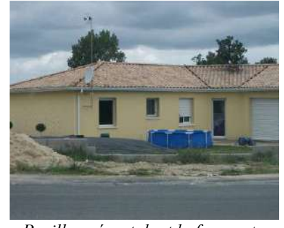
Pavillon récent dont la forme et les volumes sont en totale rupture avec le bâti ancien
