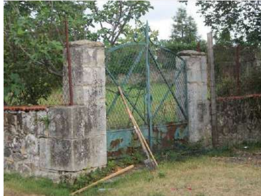
Piliers de portail
