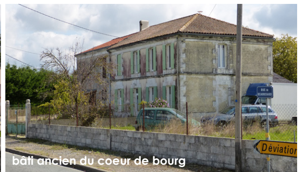
Des constructions anciennes englouties dans les développements pavillonnaires du bourg...
