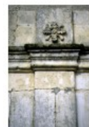
Feuille de chêne porte piétonne Rue Haute
