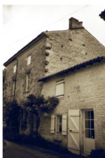
Rue du Lavoir
