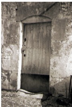
Porte à linteau délardé datant du fin 17e début 18e siècle – Petite rue
