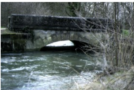
Pont « de la Prairie »
