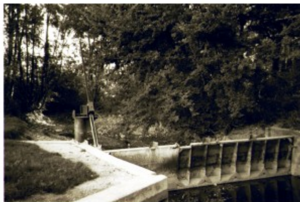
Écluse de Baqnizeau
