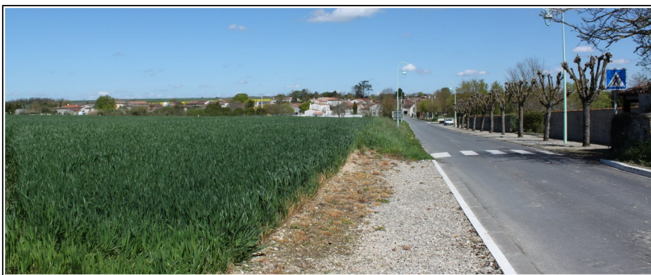
Secteur 12 entre le Bourg et le Village du Logis
