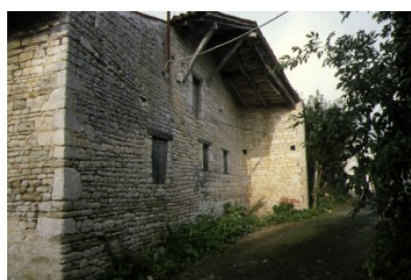
Auvent pour protéger les « mojhettes » - Rue de la mairie
