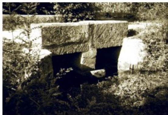
Pont « de la Fontaine »
