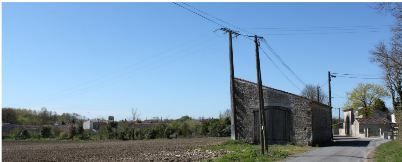
Bâtiment identifié pour changer de destination dans le projet de PLU – Vue Est
