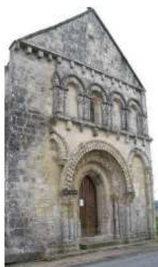
Façade occidentale Com- posée de deux registres superposés et surmontés d'un pignon triangulaire.
