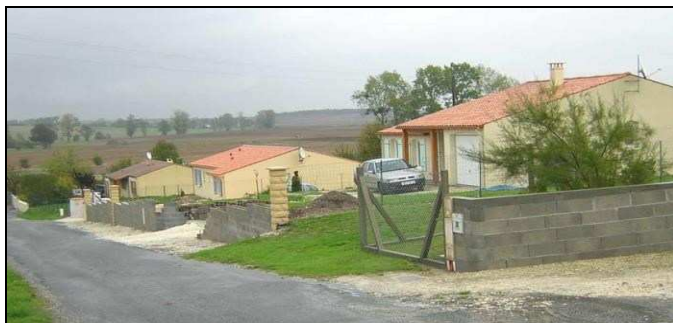
Photo n°9 : Le quartier de « derrière le bourg » constitue l'axe de développement principal du bourg. Ici la rue de Saintonge, formée de petits pavillons récents. Murets en parpaing et piliers en fausses pierres semblent faire l'unanimité auprès des nouveaux résidents.
