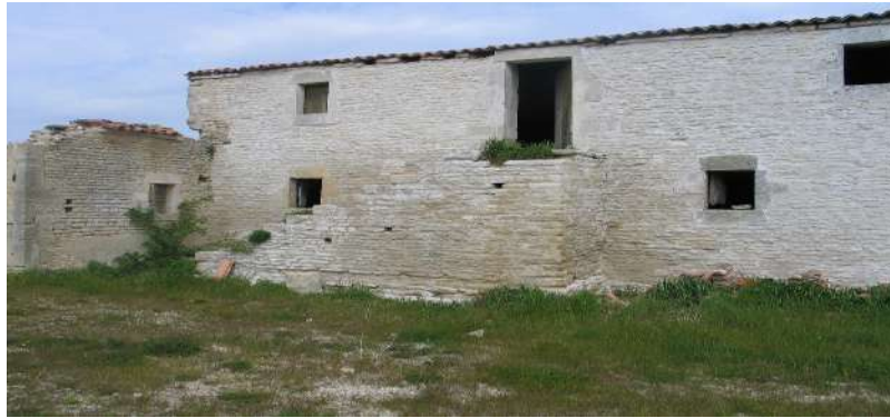
Maison avec escalier extérieur la Cabourne
