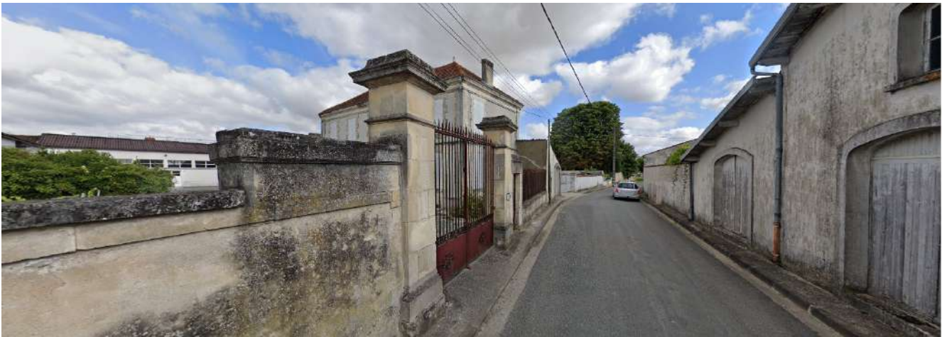
Vue Sud du site de la distillerie depuis la rue des Fins bois (Bâtiment à gauche)
