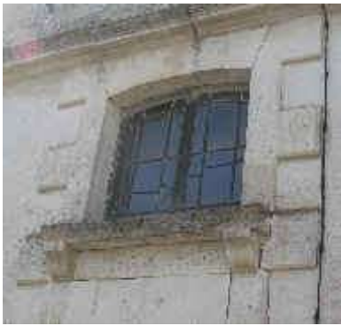
Fenêtre segmentaire avec appui saillant
