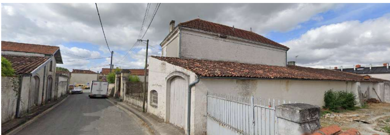
Vue Nord du site de la distillerie depuis la rue des Fins bois (Bâtiment à droite)
