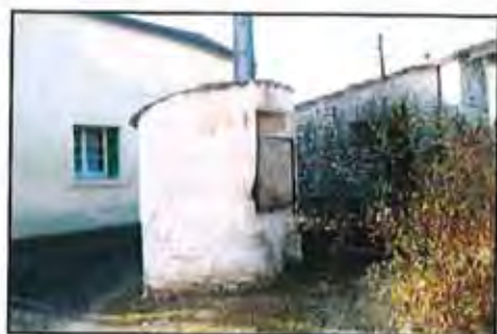
Puits restauré au « Moulin de La Laigne »
