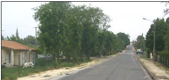
Photo n°14 : Le réaménagement programmé de la D 152 ne doit pas s'appuyer sur les motifs végétaux présents sur la commune, comme l'allée de frênes qui borde la voie D 699 ?
