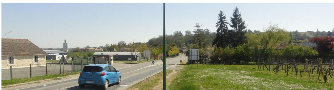
Vue d'ensemble sur la partie Nord du site depuis la RD 711. La maison intégrée au site d'activité comprend de grands conifères et une haie qui permettent d'intégrer les ateliers.
