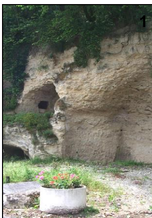
Photo n°1 : Grottes situées rue Basse du Château
