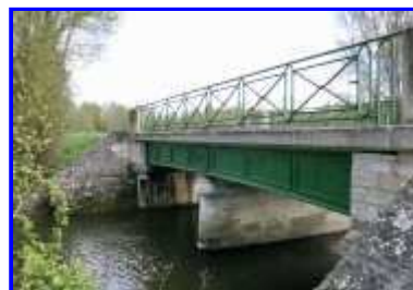
Fig. 2 La face nord du pont.
