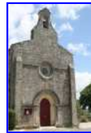
La façade occidentale de l'église.
