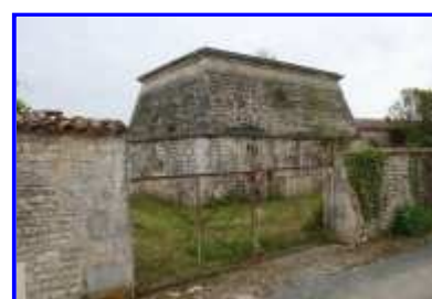
Le château d'eau depuis le nord-est.
