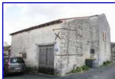
Fig. 2 La dépendance adossée.
