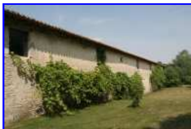
Fig. 10 Le corps de dépendances au nord du logis.
