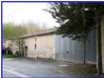
Fig. 16 Le hangar et les anciens chais.
