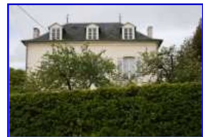
Une vue partielle de la maison de maître.
