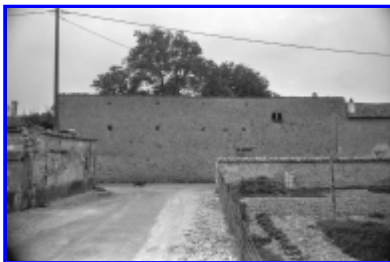
Fig. 1 La façade arrière du hangar, 1989.
