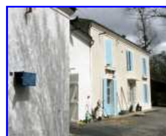
Le bâtiment principal.
