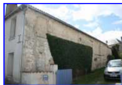
La façade nord-est.
