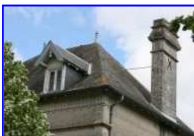
Fig. 4 Un détail de la toiture et une souche de cheminée.
