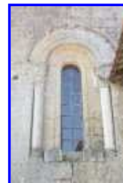
Fig. 21 Une baie de la façade nord.
