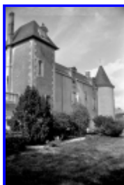
Fig. 4 La façade sud-est du logis, 1989.
