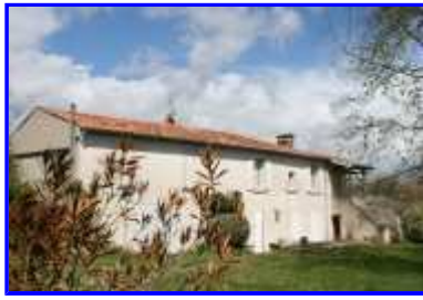
Fig. 4 La façade sud-ouest.
