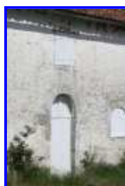
Fig. 4 La porte et la baie en plein cintre.
