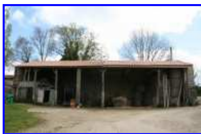
Fig. 16 Le grand hangar à poteaux de bois.
