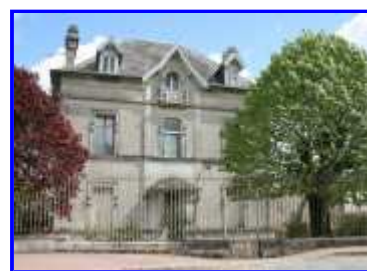
La façade principale.
