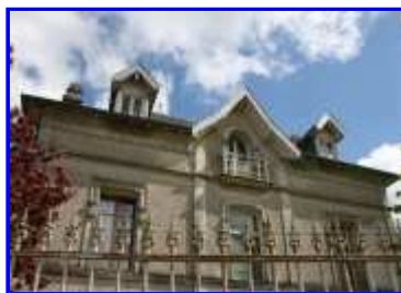
Fig. 2 Une vue des niveaux supérieurs.
