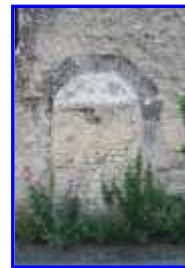
L'ancienne porte en plein cintre.
