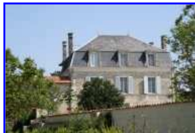
Fig. 3 La maison de maître.
