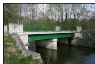
La face sud du pont.
