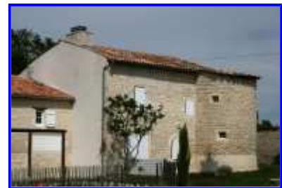
Fig. 15 Le bâtiment avec la tour dérasée.
