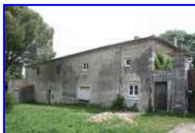
Fig. 7 La façade arrière du corps principal.
