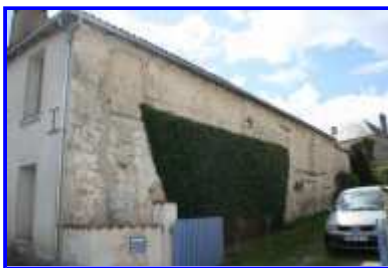
Fig. 1 La façade nord-est.
