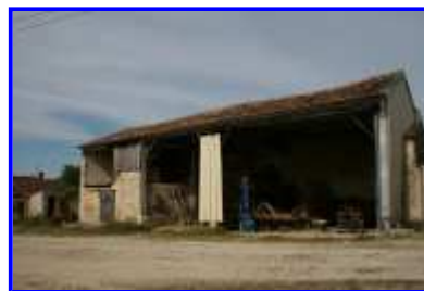
Fig. 9 Le hangar et le toit à bêtes.
