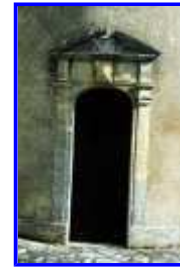
Fig. 9 La porte de la tour, 1999.
