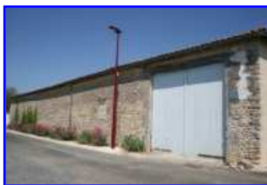
Fig. 6 Les dépendances rue du Château d'eau.
