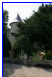
Fig. 7 Le logis depuis la cour.
