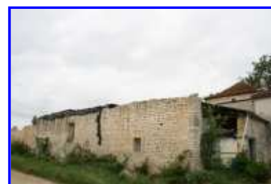
Fig. 12 Les vestiges d'un bâtiment près
