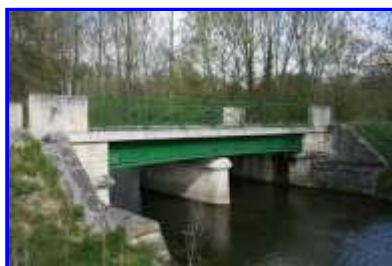
Fig. 1 La face sud du pont.
