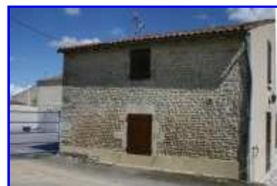
Fig. 8 La façade arrière de la cellule.
