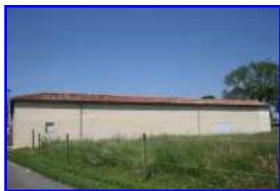
Fig. 7 Les dépendances rue du Château d'eau.
