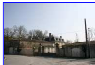
Une vue d'ensemble depuis l'ouest.
