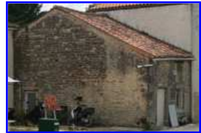
Fig. 3 Le pignon de la cellule.
