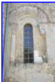
Fig. 20 Une baie de la façade nord.
