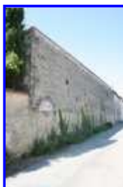
Fig. 5 Les façades arrière.
