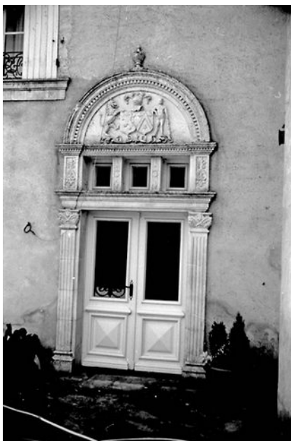
Encadrement de la porte principale à préserver
