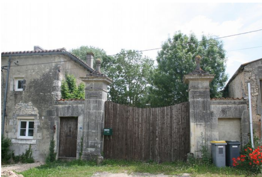
Encadrement de la porte et piliers du portail à préserver
