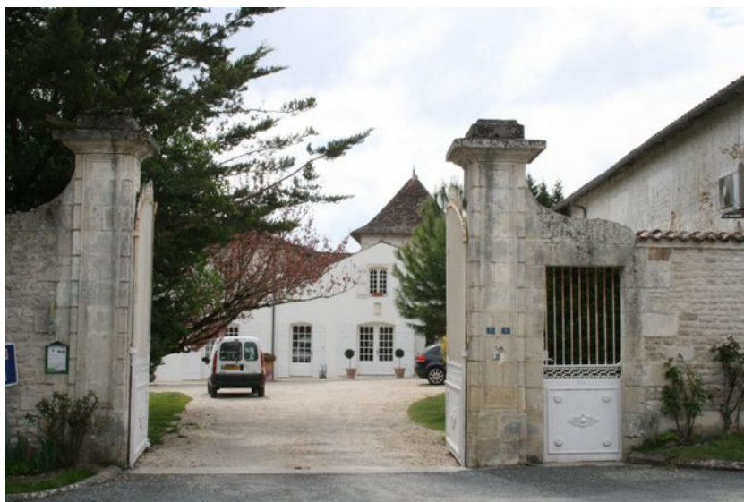
Encadrement de la porte piétonne et piliers du portail à préserver
