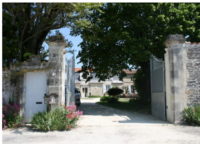
Encadrement de la porte et piliers du portail à préserver
