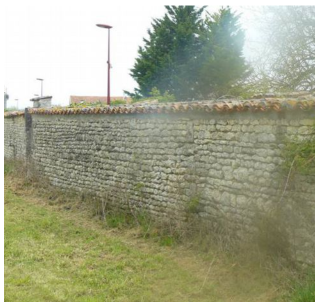
Mur d'enceinte du château d'eau, La Chapelle Bâton (ouvertures accordées)
