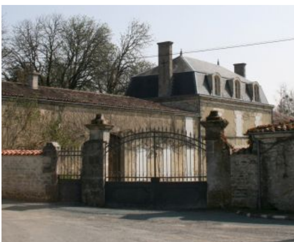
Piliers du portail à préserver
