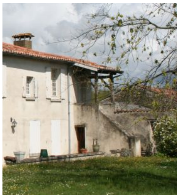
Escalier et son ballet à préserver
