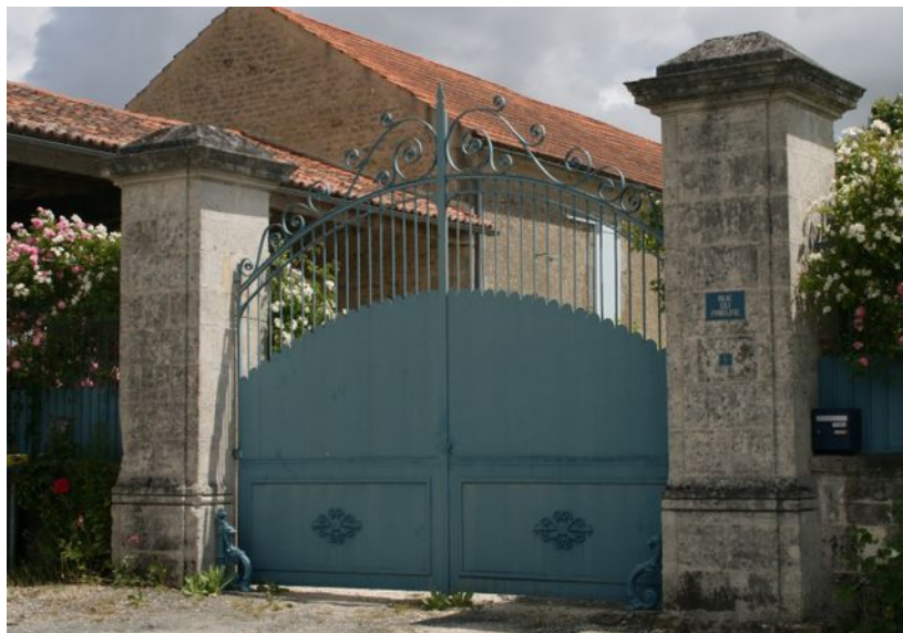
Piliers du portail à préserver
