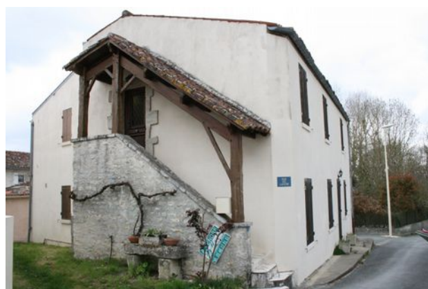
Escalier et ballet à préserver
