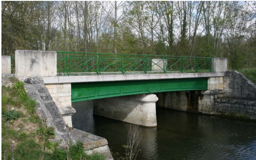
Pont sur la Boutonne, RD 127
