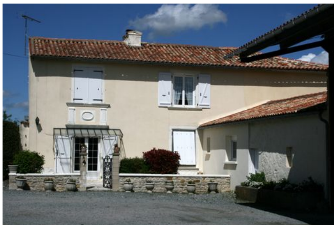
Travée gauche de la façade principale à préserver
