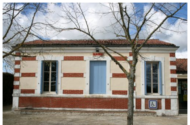
Façade de la Mairie à préserver, 10 rue des Tilleuls à Antezant
