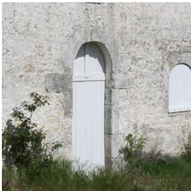
Encadrements de la porte et de la fenêtre à préserver
