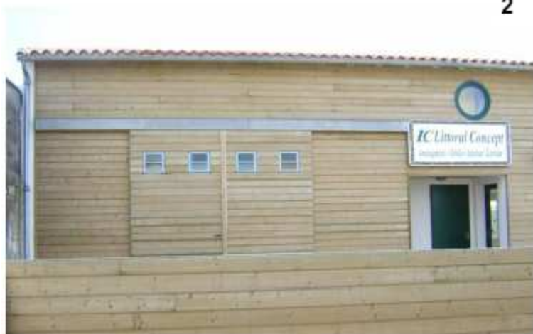
Bâtiment d'activité en bois
