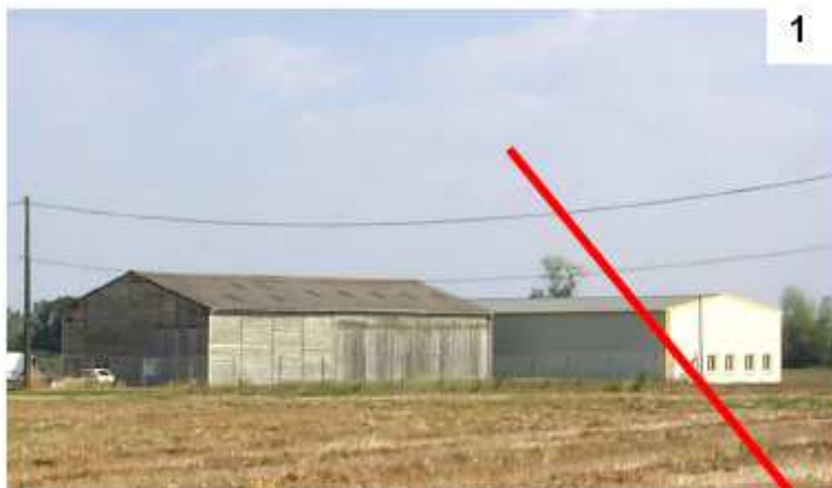
A droite : hangar agricole métallique avec un bardage blanc clair, et donc très visible en hiver (sols nus). A gauche : bâtiment agricole en bois avec toiture métallique de la même teinte. Grande discrétion, même en hiver.
