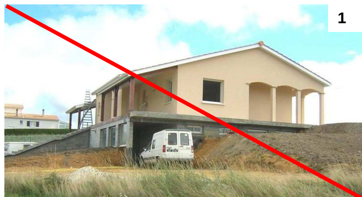
Implantation sur plateforme sur-élevée, importants mouvements de terrains
