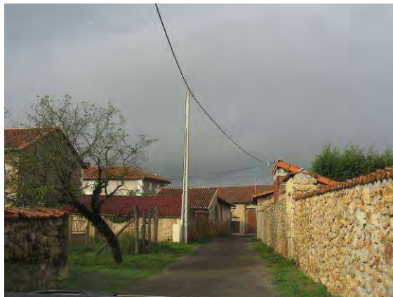
Le Bourg, voirie sur laquelle s'aligne les murs de clôture
