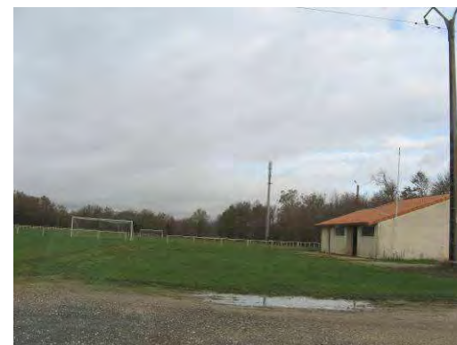
Terrain de football et vestiaires, situés en dehors du bourg
