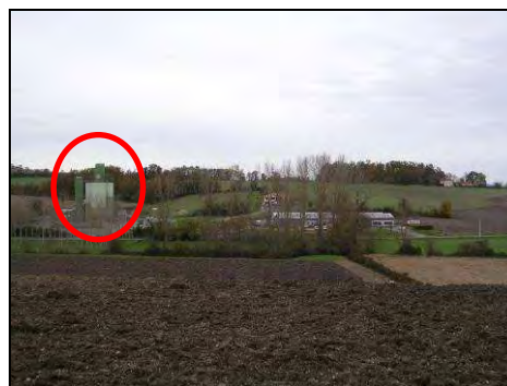
Vue sur le silo depuis Chez Peny
