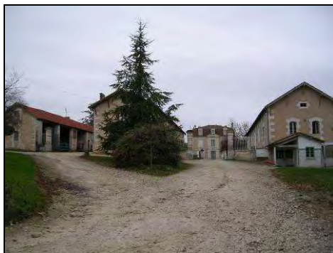
Ancien hôpital de Romainville
