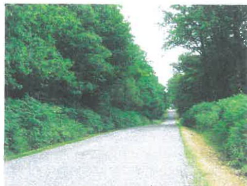
Route de St Quentin à Pressignac
