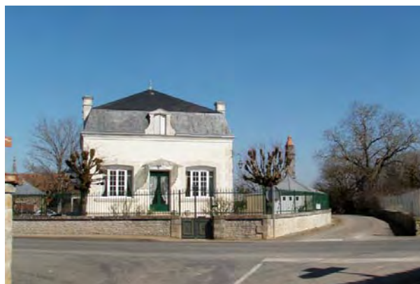
Maison bourgeoise XIX et ses deux annexes à toiture zinc, à huit pans et à arêtes à arc infléchi.
