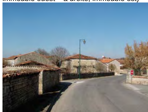
Murs de clos sur la RD 27
