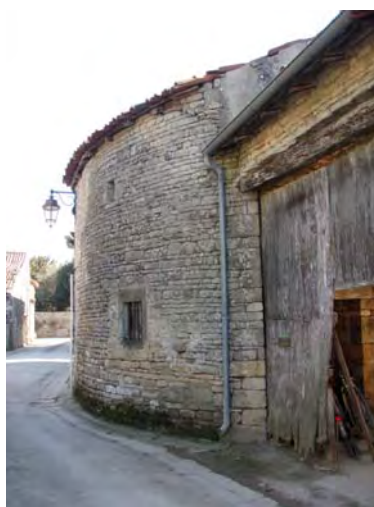
Anciens murs aux appareillages d'intérêt (à droite – immeuble sur rue des écoles, parcelle 83 ; à gauche – immeuble sur rue de l'avenir, parcelle 37
