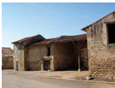
Maison ouvrière et ses dépendances attenantes, à l'ouest du manoir
