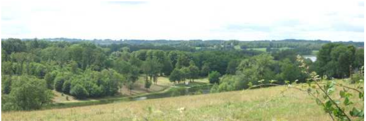
Vue sur barrage depuis Servolles
