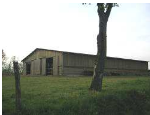
Bâtiments agricoles (Bréjoux)
