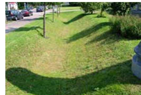
Noue enherbée accueillant les eaux pluviales, d'une largeur de 2 à 3 mètres
