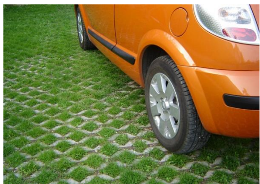
Exemple d'aménagement des stationnements en vue de limiter l'imperméabilisation
